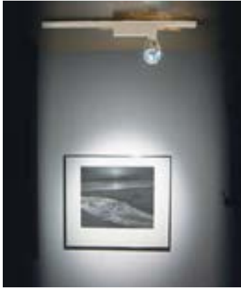
Bild 8: Effiziente Innenraumbeleuchtung mit Hochleistungs-LEDs, wie sie z.B. in Galerien eingesetzt werden
