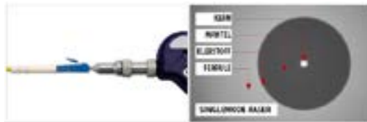
Abbildung 6: Prüfung des Patchkabels mit dem Videomikroskop
