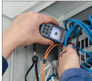
Bild 5: Steckerinspektion mit Autofokus im Feld (Foto: AFL)
