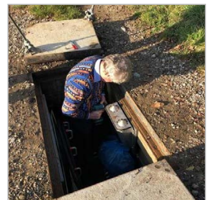
Abbildung 4: Doppelschachtsensor
