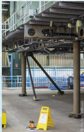
Im Baudock (links) sorgen selbstnivellierende Laser (Mitte) und Präzisionsdetektoren (rechts) für millimetergenaue Positionierung der tonnenschweren Sektionen.
